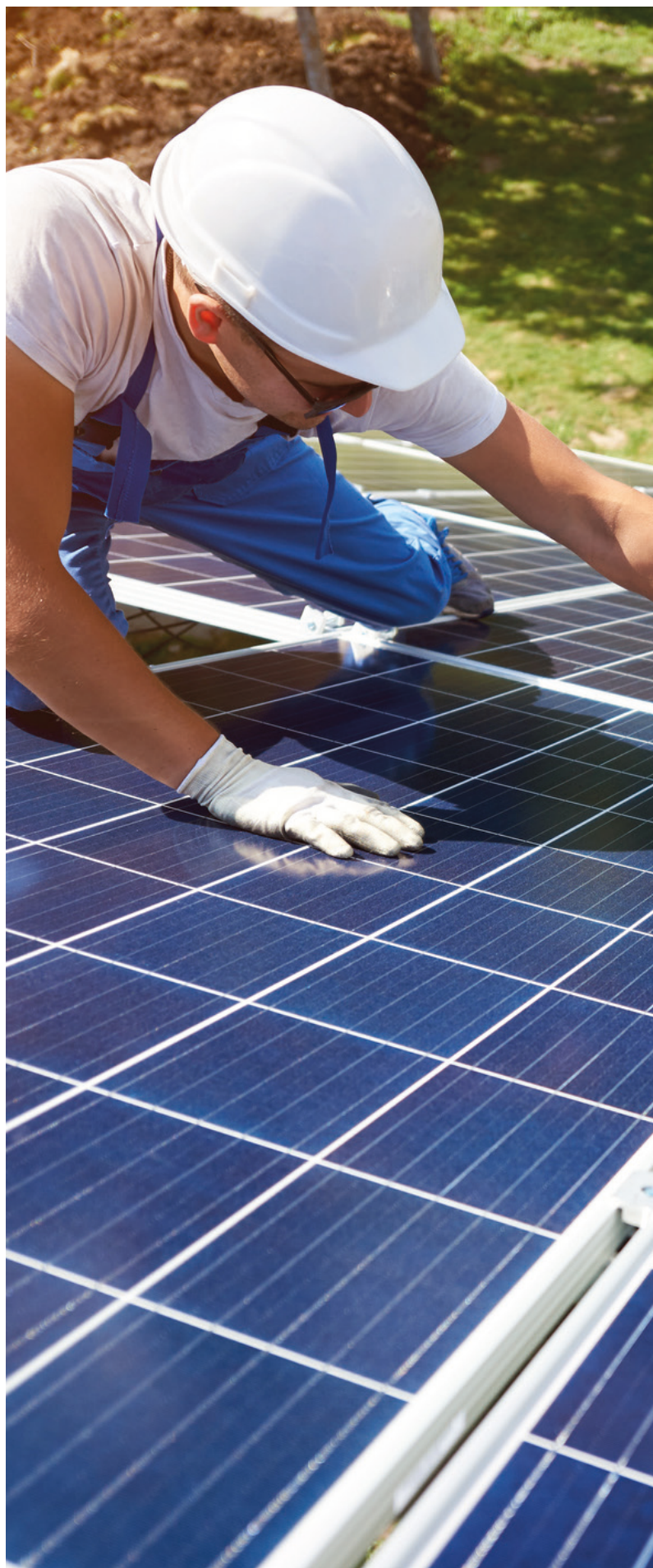
Jestliže plánujete využít sluneční energii na ohřev vody a přitápění, vhodná je fototermika. Ideální je například pro nízkoenergetické domy. Foto redakce
